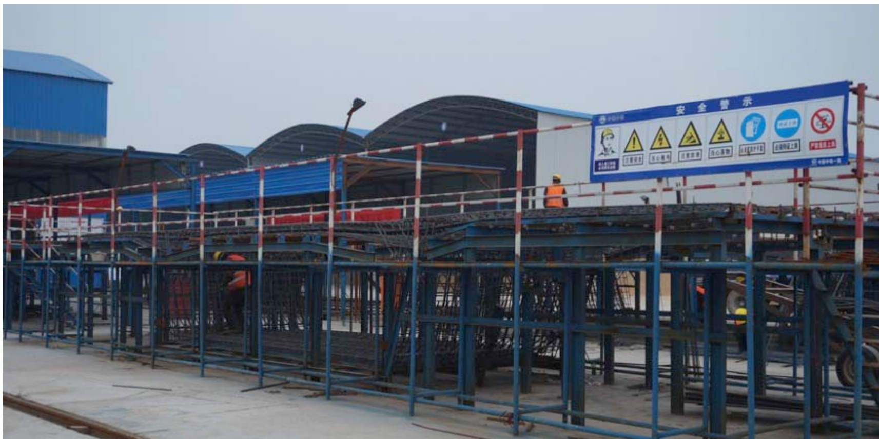
钢筋绑扎台座
