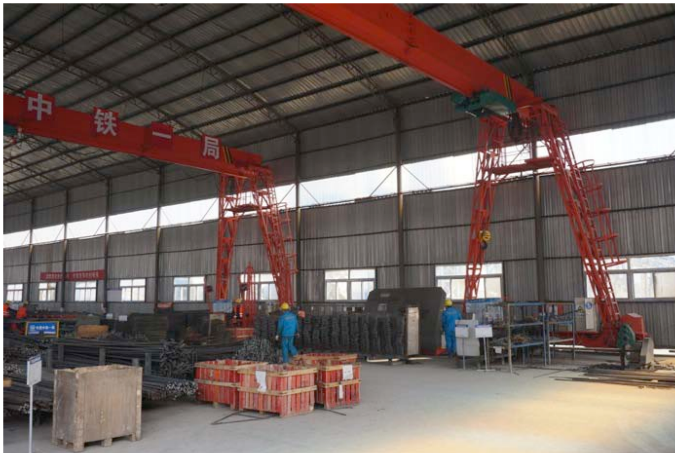
钢筋加工车间
